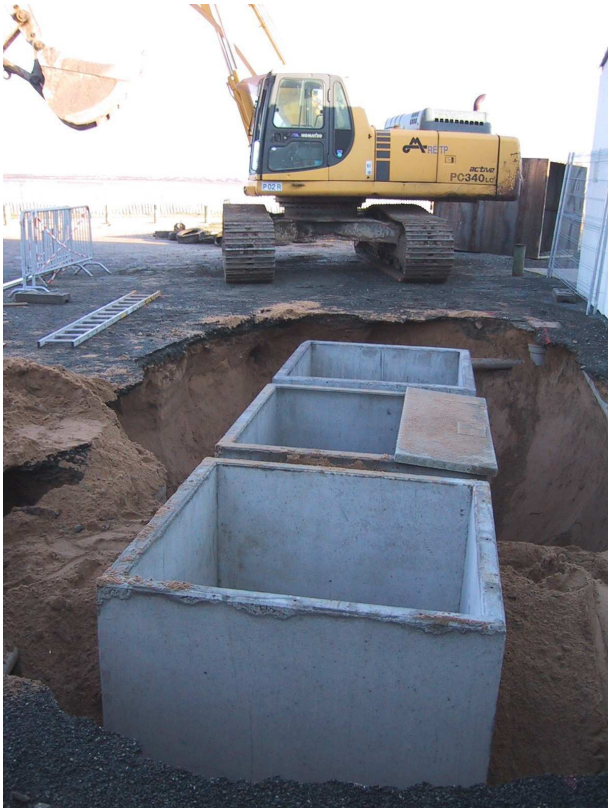
Travaux de mise en place de conteneurs enterrés
